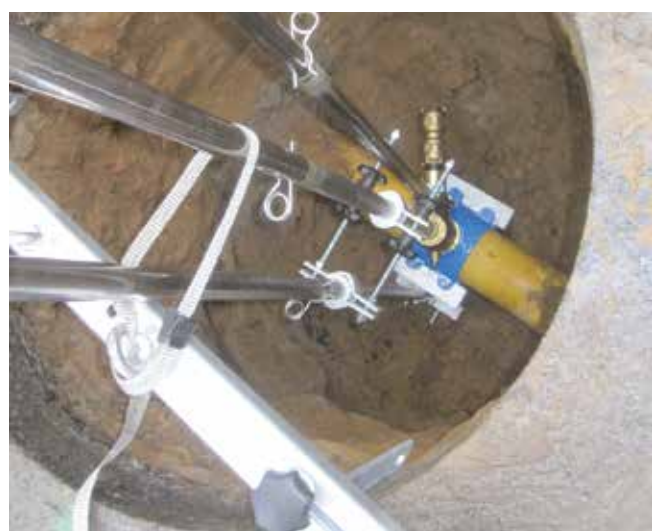
Montáž přípojovací armatury
