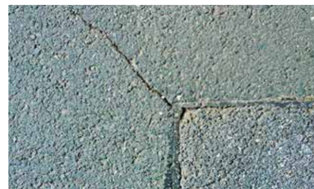
Hranatá stavební jáma – nevyhnutelné následné škody.
