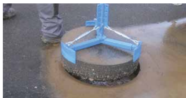
Odstranění vyvrtaného jádra
