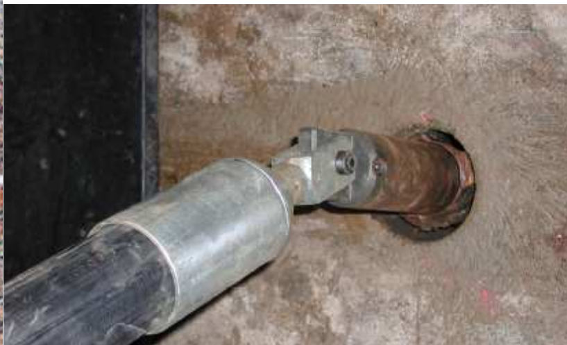
Vtahování PE potrubí
